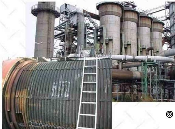
© Brand an Hochofenanlage nach korrosionsbedingter Thermoölleckage
